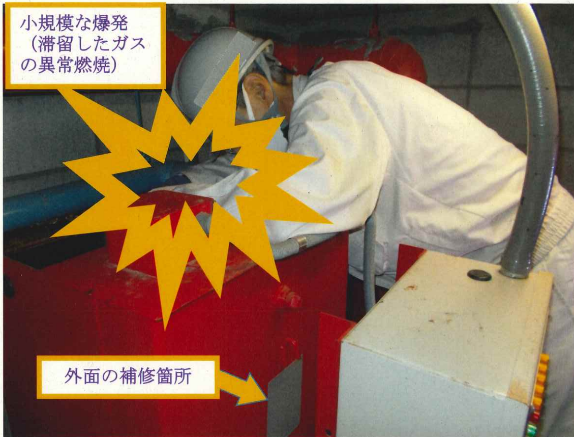
写真3 消火栓ポンプ呼水槽の内面補修時の様子 (模擬)
