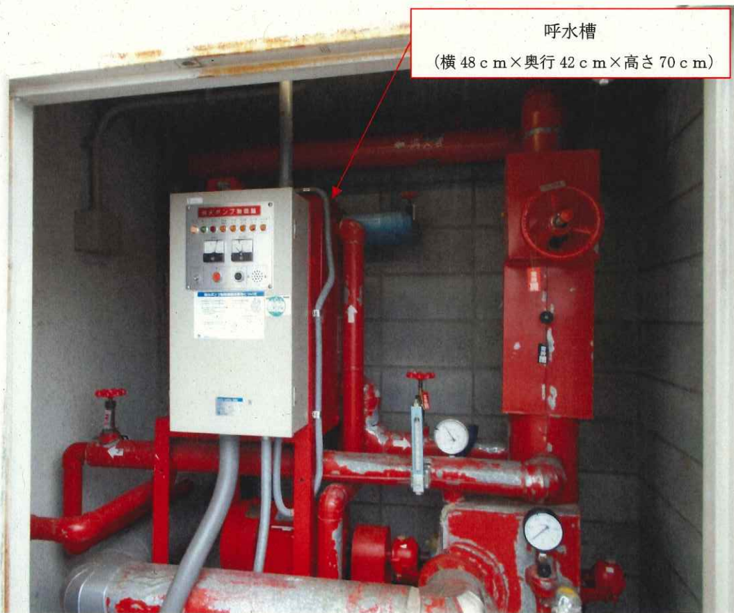
写真2 消火栓ポンプ室内 (呼水槽は操作盤裏)
